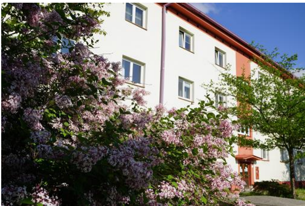
Obrázek 4 Objekt Odborářská 677, Ostrava
